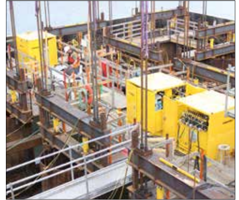
▲ Niestandardowa pompa hydrauliczna do układu wprowadzania jezdni mostowej.
